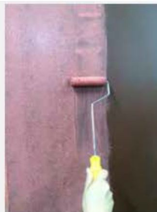
ขั้นตอนที่ 1 ใช้ลูกกลิ้งสีเพื่อทาสี SuperShield Décor สองชั้นที่จำนวน 1 รอบ Apply SuperShield Décor effect coat with Paint Roller
