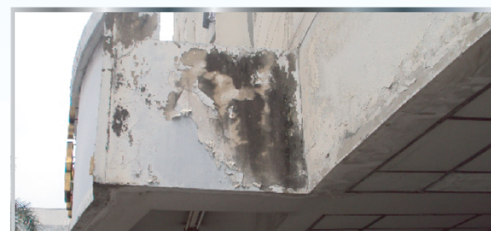
เชื้อราและตะไคร่น้ำ (Fungi and Algae)
