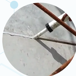
พ่นังคอนกรีต
